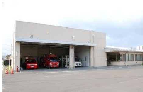
石巻消防署河南出張所
