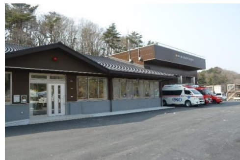
東松島消防署鳴瀬出張所
