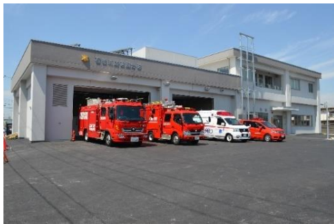
石巻消防署西分署
