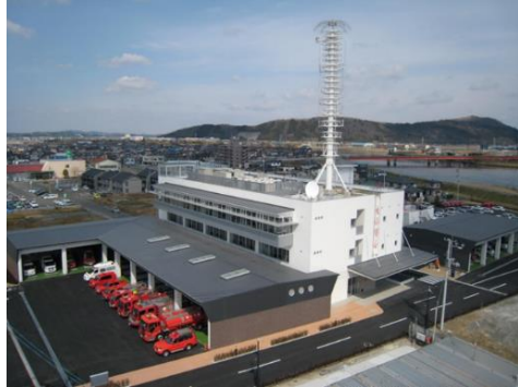
消防本部・石巻消防署
